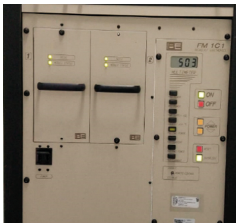
Figura 11. Vista frontal del amplificador y transmisor de FM con una potencia de 1 kW inicial y después multiplicada por los elementos de la antena mediante una guía de onda presurizada (cable que conduce la energía a la frecuencia de 103.2 MHz).
